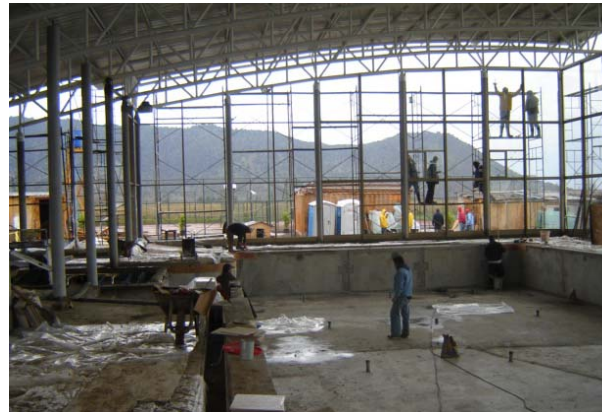
PISCINA TEMPERADA EN OBRAS
