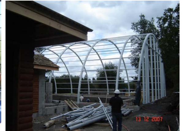
PISCINA EN CONSTRUCCION
