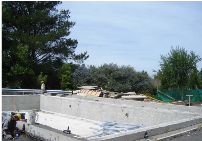
PISCINA EN CONSTRUCCION
